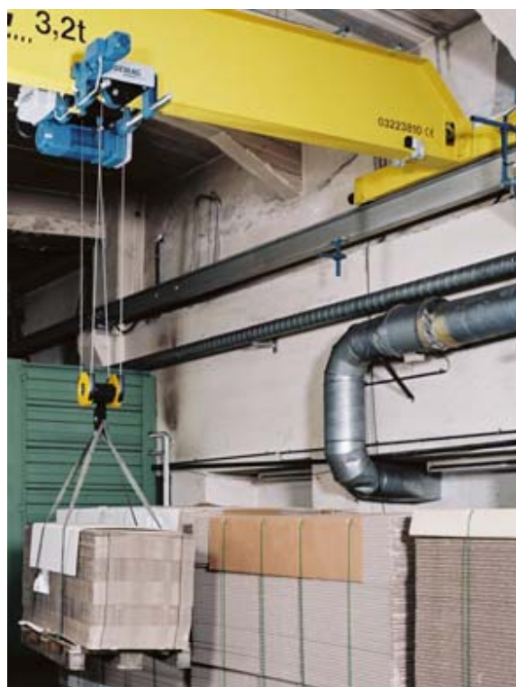
Figura 1. Movimiento de una carga mediante puente grúa y eslingas textiles
