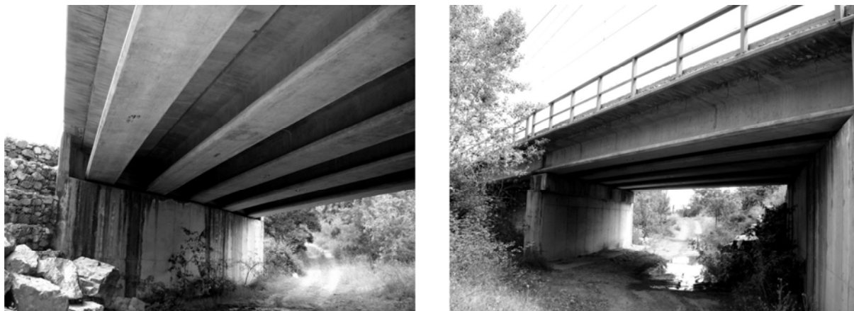
Figura 3. Imágenes del puente Arroyo Bracea II
