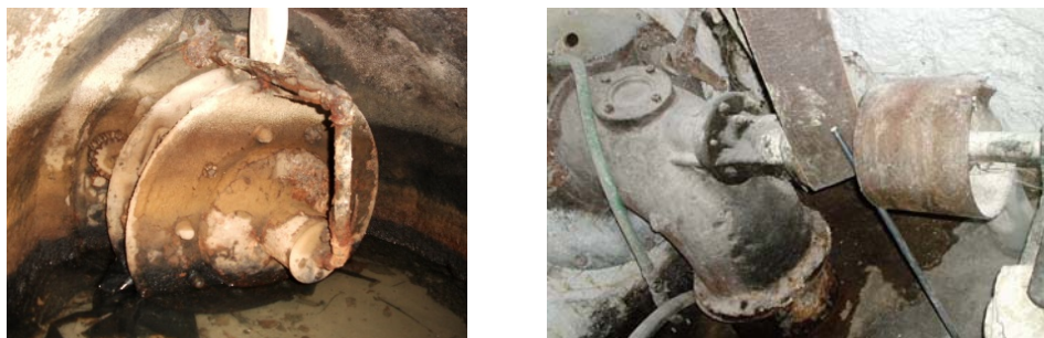
Figura 8. Vista exterior de la turbina, y eje y tubo de aspiración desde el interior.
